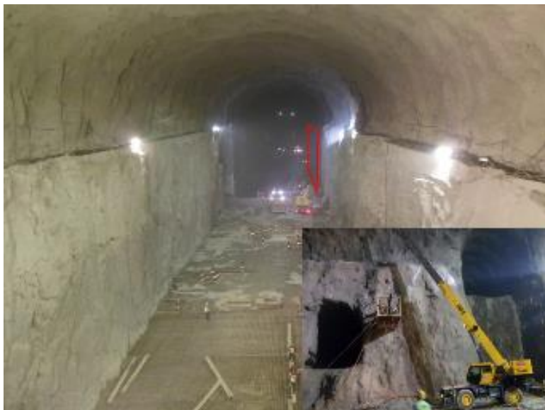
Figura 11 – Caverna da Central Principal. Aplicação do tratamento geotécnico de reforço entre o pk 0+095 e 0+145 e entre as cotas 640,85 e 631,00
